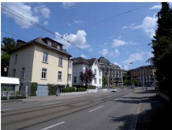
Büroliegenschaft Asylstrasse 41 in Zürich Hauseingang auf der Rückseite
